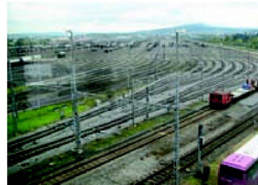
Abb. 5: Welche Zukunft haben funktional einseitige und flächenextensive Anlagen in Räumen nationaler Bedeutung (hier Rangierbahnhof Spreitenbach und Dietikon).
