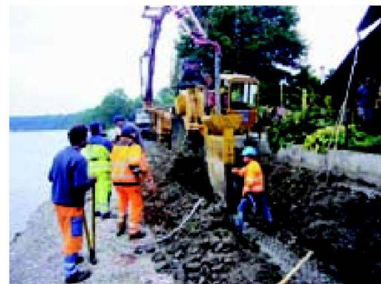
Abb. 4: Bau einer Betondichtwand.
