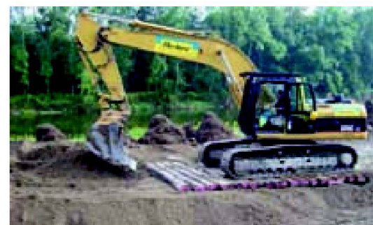
Abb. 3: Der Schutz vor unerwünschten Verdichtungen in losem und feuchtem Boden erfordert diverse Massnahmen. Unser Beispiel: Der Bagger fährt auf Holzmatratzen.
