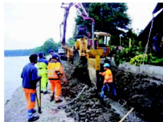
Abb. 4: Bau einer Betondichtwand.
