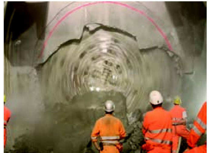
Abb. 12: Bohrkopf der Tunnelbohrmaschine im Moment des Durchschlags.
