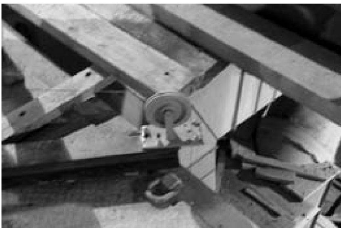
Abb. 6: Umlenkrolle mit Lotdraht.
