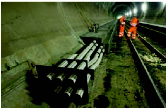
Abb. 8: Bau des Banketts.
