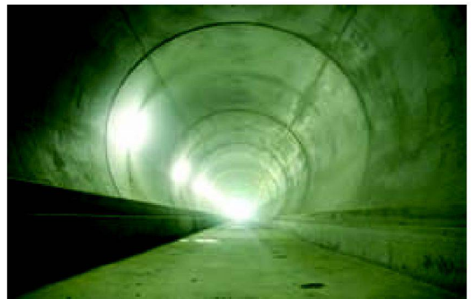
Abb. 9: Fertiger, ausbetonierter Tunnel.
