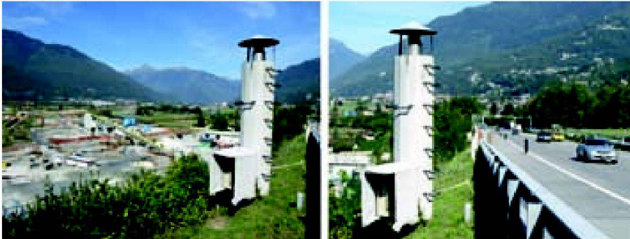
Abb. 2: Messpfeiler: Automatische Überwachung entlang der Autobahn A2 – das Monitoringsystem detektiert Bewegungen mit einer vorgegebenen Sensitivität von 3 mm.
