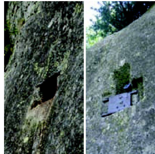
Abb. 2 und 3: Richtungsmarke Göschenen Nord: Metallplatte mit Visierloch 1 cm in Felswand nördlich von Göschenen; Richtungsmarke Göschenen Süd: Metallplatte mit Visierloch 3 cm in Felswand südlich von Göschenen. Mit LED-Solar-Lampe für nächtliche Vermessung.
