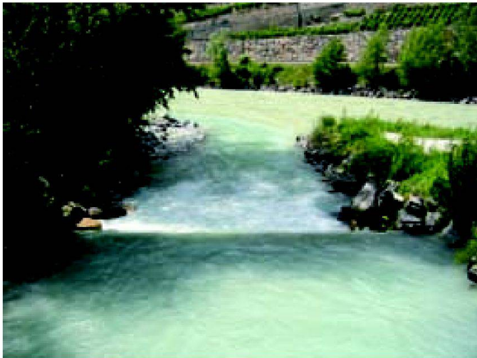
Fig. 1: Embouchure de la Borgne canalisée dans le Rhône en Valais: au premier plan, le seuil faisant obstacle à la remontée des poissons (LCH/EPFL).
