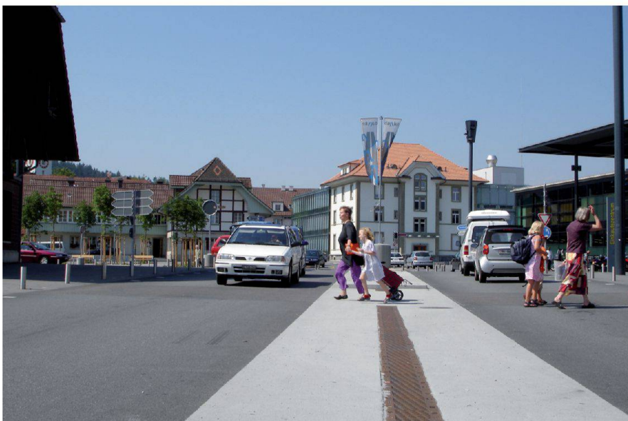
Abb. 3: Innovatives Mobilitätskonzept: Sanierung Schwarzenburgstrasse Köniz: 17 000 Fahrzeuge pro Tag, Tempo 30 und freie Überquerbarkeit. (Oberingenieurkreis II/Metron AG, 2005). (Foto © Gemeinde Köniz.)
