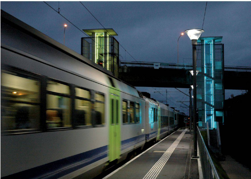
Fig. 6: Revalorisation de la zone urbaine: A Niederwangen, des tours assurent la liaison entre le centre, les quartiers d'habitation et les zones artisanales séparés par l'autoroute A12. (Clemençon + Ernst Architekten/Bächtold AG, 2010). (Photo © Gemeinde Köniz.)
