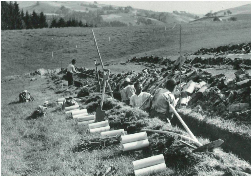
Abb. 2: Rüeggisberg 1944. Aushub der Drainagegräben von Hand 2 .
