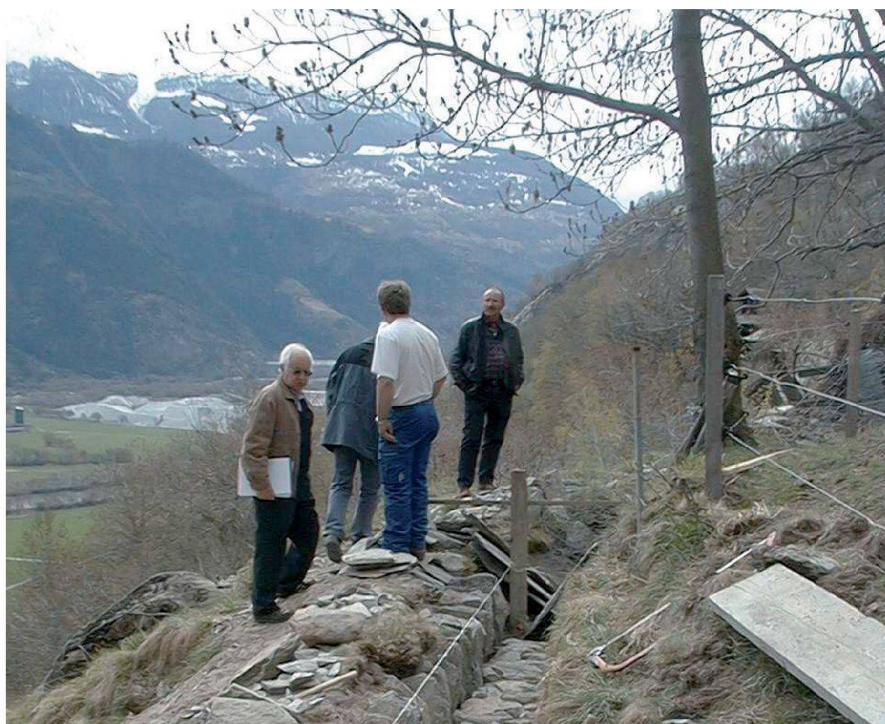
Abb. 5: Baltschieder-Wyngartneri-Tretschbord im Bau.
