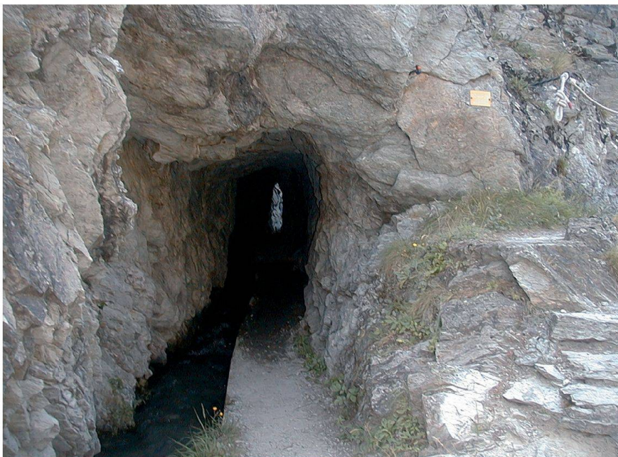
Abb. 2: Eggerberg-Gorperi-Stollen und Trasse alte Suone.
