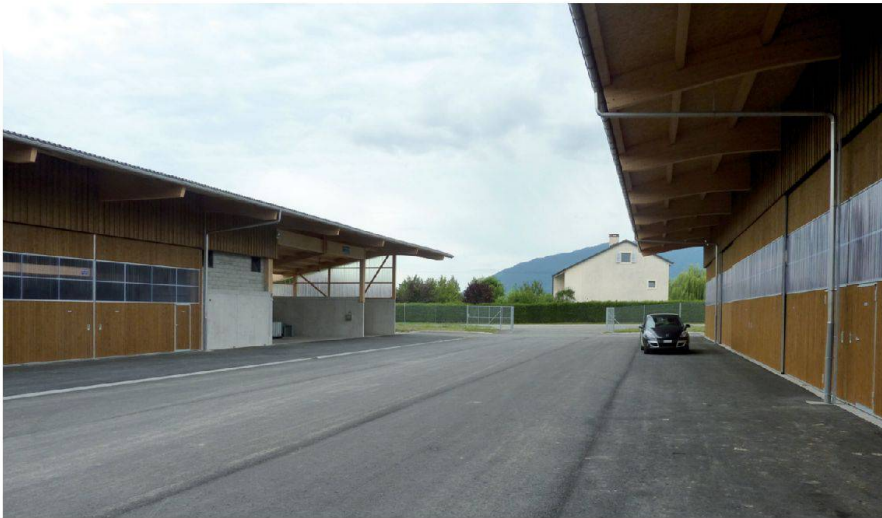
Fig. 3: Vue sur les hangars. Chaque travée comporte une cellule identique fermée par une porte coulissante.
