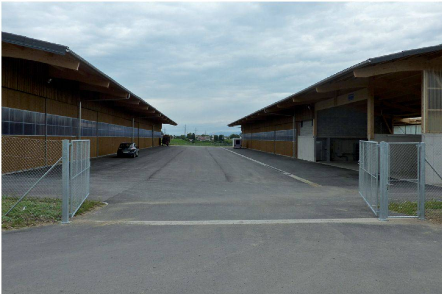
Fig. 1: Vue sur les hangars depuis le portail d'entrée.
