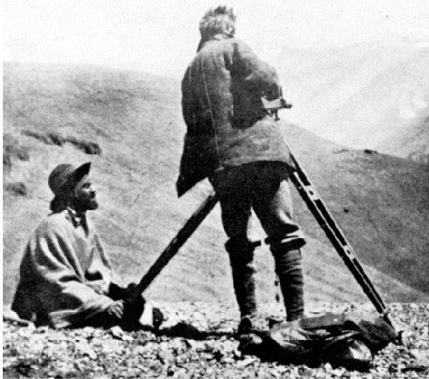
Abb. 2: Robert Helbling am 24. Februar 1909 bei ersten Vermessungsarbeiten auf dem Cerro Rotondo. Der chilenische Maultiertreiber «el Negrito» hilft bei starkem Wind den Phototheodoliten zu stabilisieren (aus: Larden 1974).
