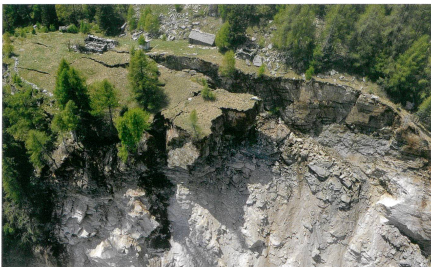
Fig. 3: Glissement de terrain à Feldweid, dans l'Entlebuch ( www.planat.ch ).
