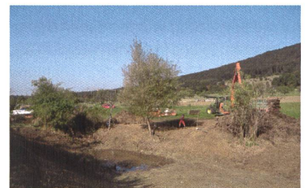
Abb. 1: Weiheranierung in der Gesamtmelioration Blauen BL, © LZE, Ressort Melioration.
