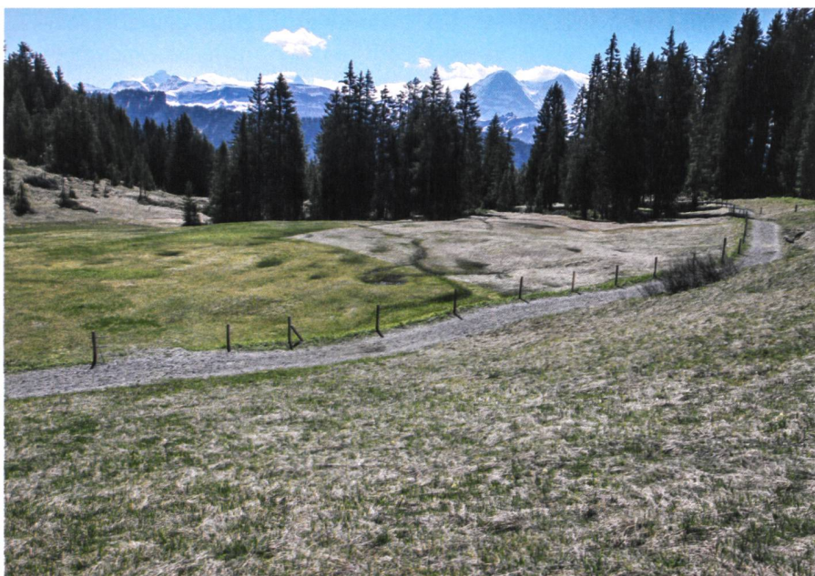
Fig. 1: Situation typique d'un chemin agricole traversant une zone de biotopes marécageux (Stouffe, commune de Habkern, BE).
