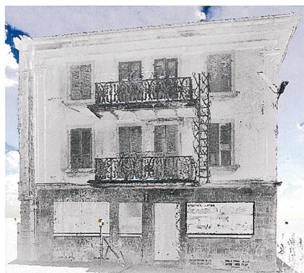
Fassadenaufnahme mit Laserscanning Punktwolke.
