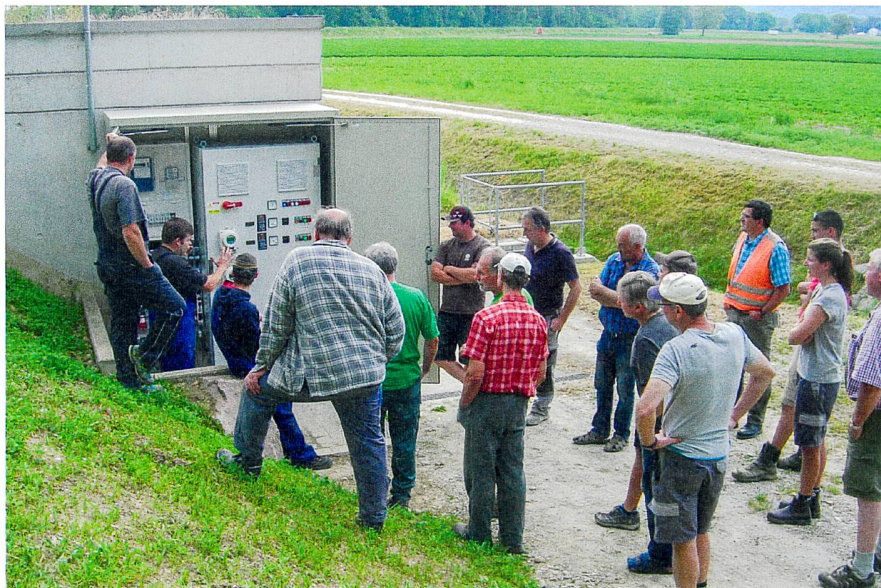
Abb. 18: Instruktionen an der Steuerkabine anlässlich der Vorabnahme im Mai 2017.
