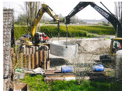
Abb. 7 und 8: Versetzen des Pumpenschachtes des neuen Entwässerungspumpwerkes.
