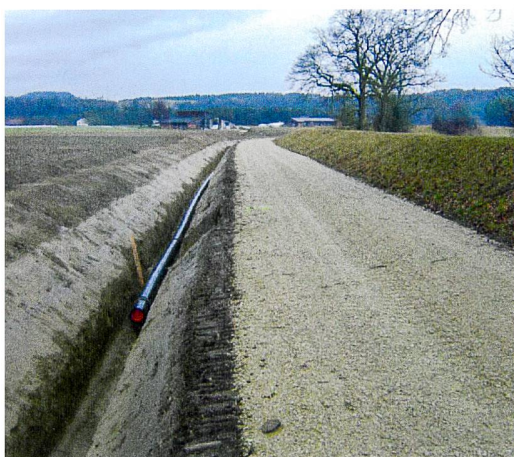
Abb. 17: Bau der Versorgungsleitung.
