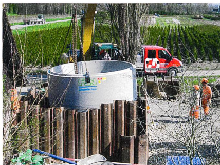
Abb. 7 und 8: Versetzen des Pumpenschachtes des neuen Entwässerungspumpwerkes.
