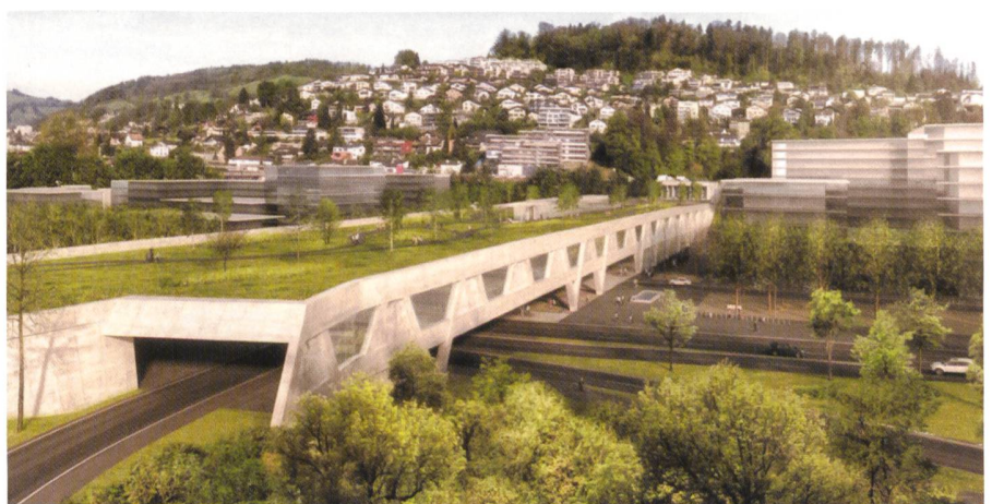
Abb. 7: Überdeckung des Tunnelportals des neuen Autobahnbypasses.
