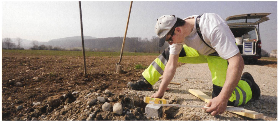
Fig. 4: Specialista di terminazione al lavoro.
