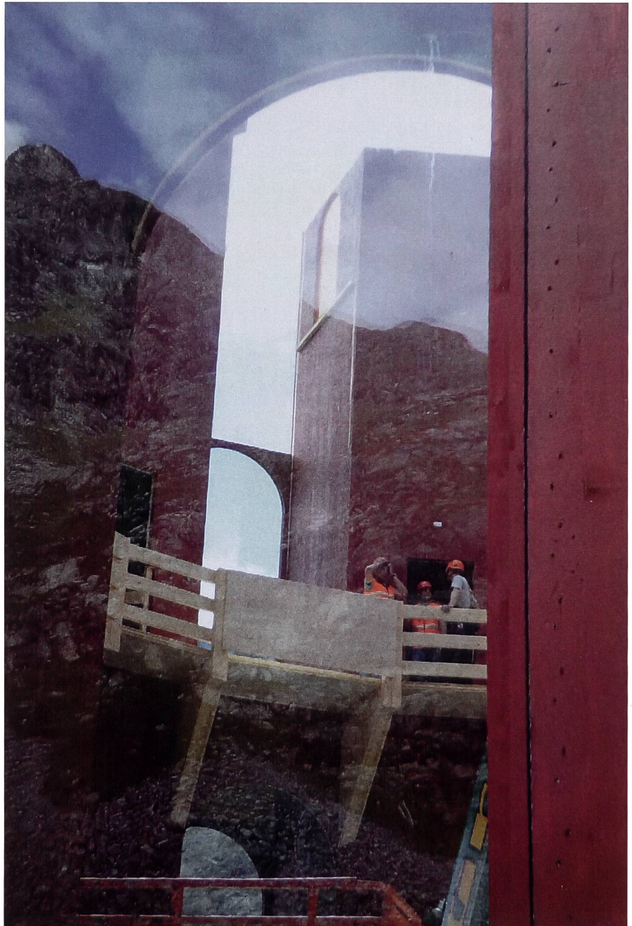
Abb. 2: Baustelle des Theaterturmes von «Origen» (Giovanni Netzer und Walter Bieler) auf dem Julierpass am 7. Juli 2017: Durch die Spiegelung in einem der bereits eingesetzten, «gotischen» Fenster vereinen und überlappen sich Technik, Kultur und Natur als Sinnbild einer «anderen Kulturtechnik» (Foto: Fritz Zollinger).
