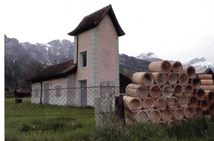
Abb. 3: Pumpstation der Meliorationsgenossenschaft mit Trafostation (Foto MGR).
