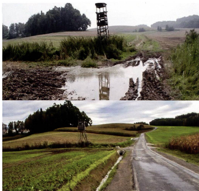
Abb. 5: Beispiel für den Güterwegebau und die Verbesserung des Entwässerungssystems im Rahmen einer Zusammenlegung in Südwesten Polens (vorher/nachher) (Foto MRiRW).
