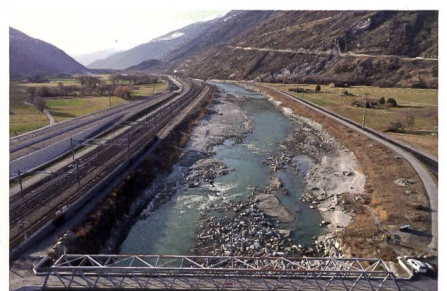
Abb. 5: Erstellte Aufweitung in Fliessrichtung.
