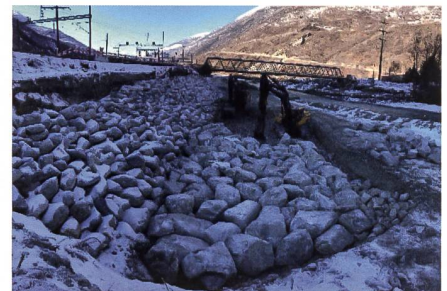
Abb. 3: Bau Leitwerke.
