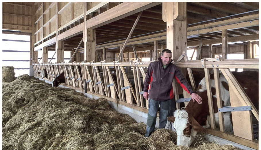
Abb. 1: Willy Helfenstein im weitgehend hölzernen Stall. Das selbst gefertigte Fressgitter aus Eschenholz lässt sich zentral auslösen.
