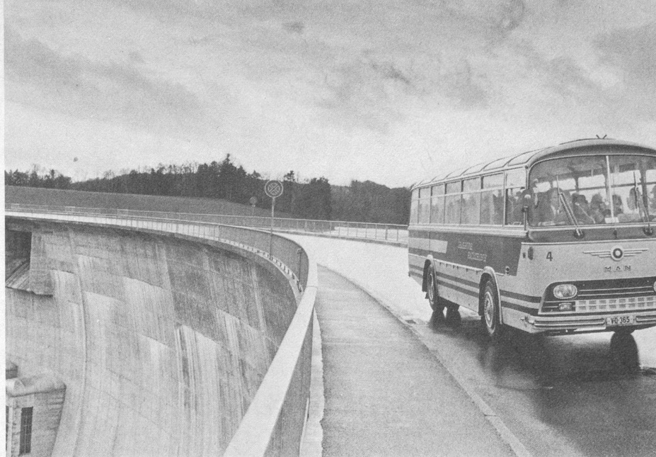
La Suisse moderne : sur le barrage de Schiffenen.
