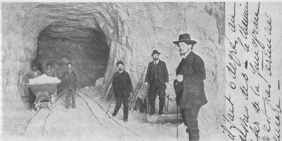
Ausbruch der Station Eigerwand. — Materialförderung durch den Hauptstollen.
