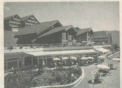
Le centre thermal d'Ovronnaz
