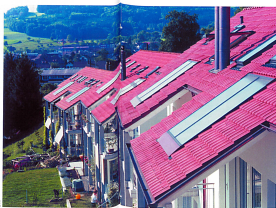
Les panneaux solaires sur le toit offrent une source énergétique d'appoint intéressante et avantageuse sur le long terme.
