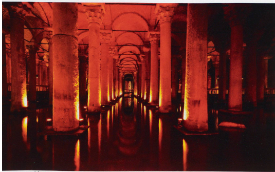
Longtemps les Stanbouliotes ont pêché des poissons depuis leurs caves. Ils ignoraient que la Citerne basilique, immense réservoir d'eau douce, se trouvait sous leurs pieds.
