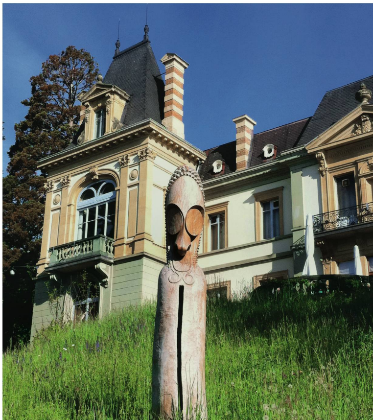
Un gros travail de rénovation pour le MEN.
