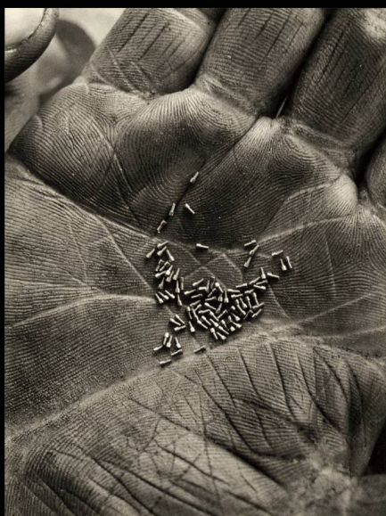
Usine de machine-outil.
