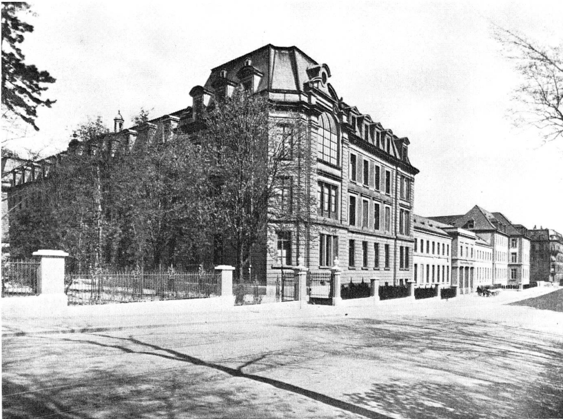
Abb. 9a: Der an das alte Spitalgebäude (links) in den Jahren 1926–1929 angebaute Verwaltungs- und Universitätstrakt (Mitte) mit der neuerbauten gynäkologischen Station (rechts). Das Hauptportal, das ehemals an der Klingelbergstraße war, befindet sich seither an der Schanzenstraße (11)
