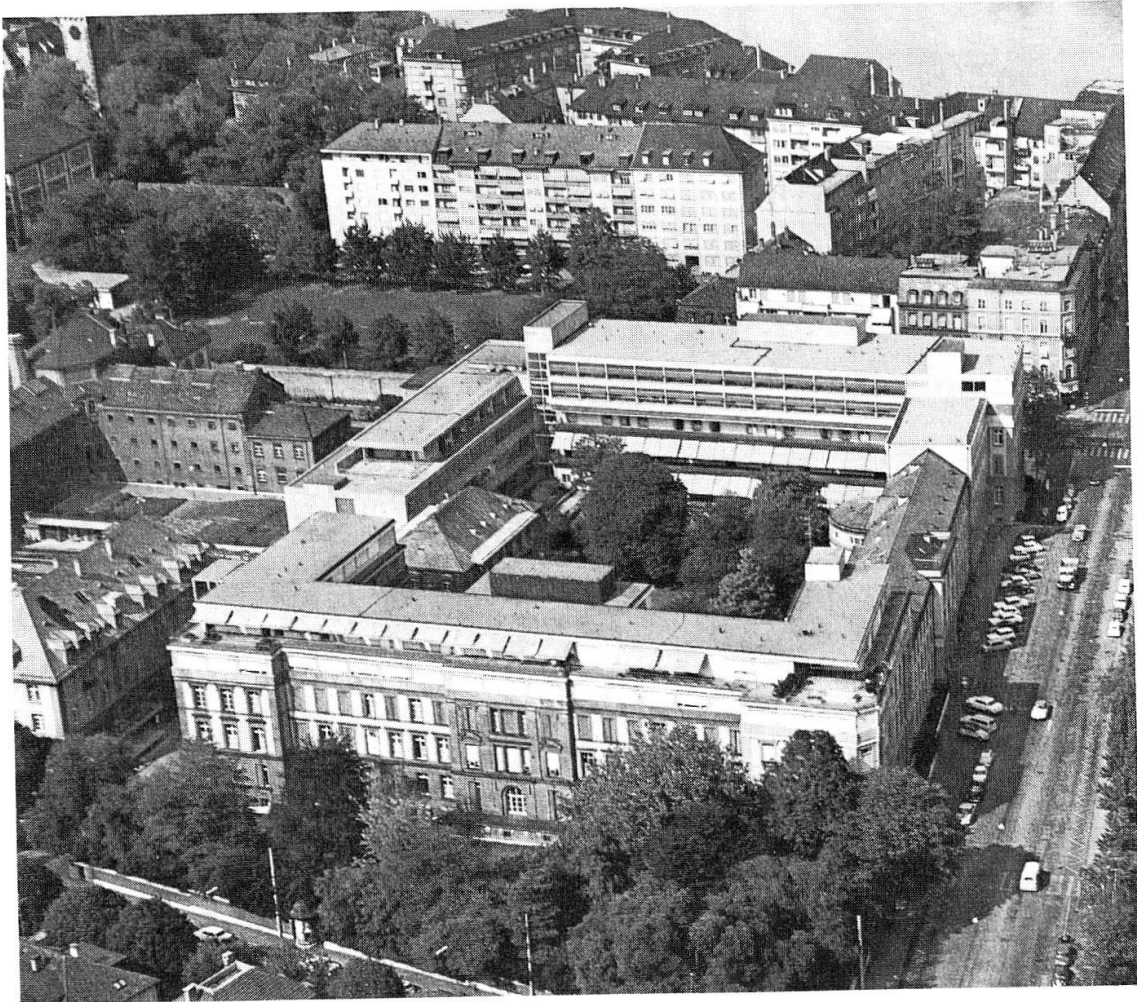
Abb. 11: Die Erweiterungsbauten zwischen 1955 und 1968 bestanden nebst einer durchgreifenden Modernisierung vor allem in einer Aufstockung der Geburtshilfe (vorne) und einem Ausbau und Aufstockung der Gynäkologie (hinten). Auch der Universitätstrakt (rechts) wurde modernisiert. An der Wilhelm-His-Straße (links) entstand ein neuer Operations- und Labortrakt. Hinter dem Frauenspital (links) das Schällemätteli mit der Strafanstalt. Im Norden (oben) der Rhein und das St. Johannstor, im Vordergrund die Klingelbergstraße und rechts die Schanzenstraße
