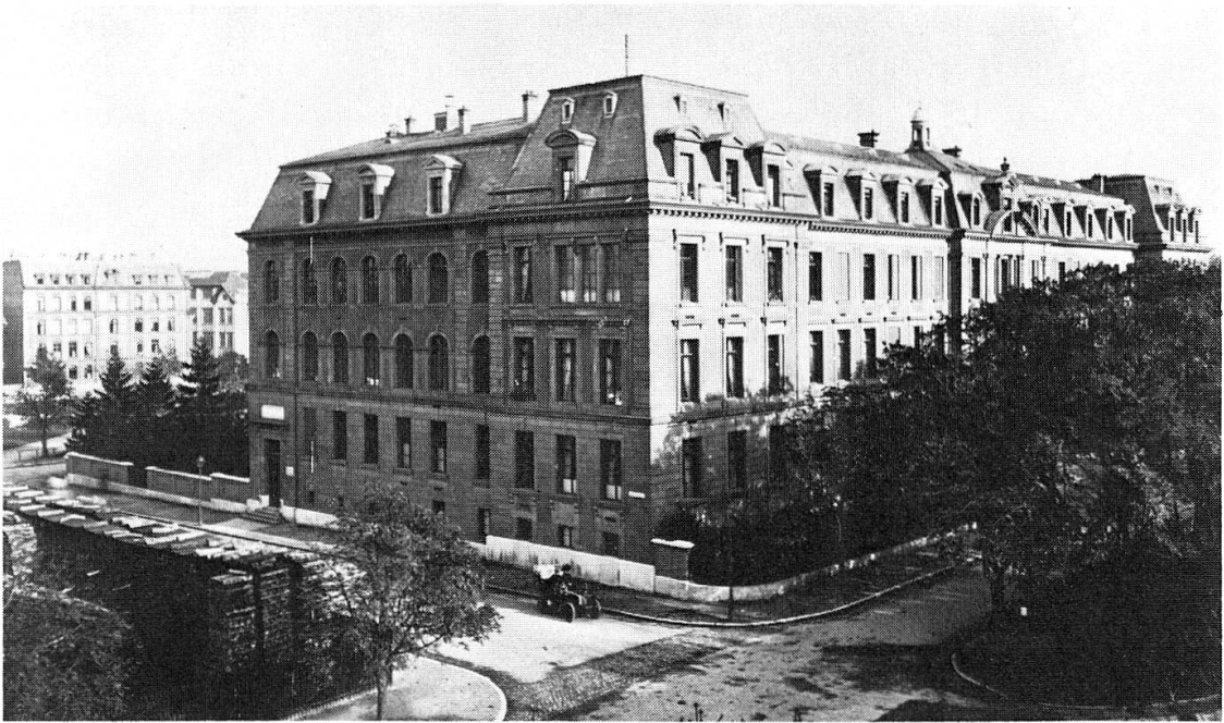
Abb. 5: Das 1893–1896 erstellte Gebäude des Basler Frauenspitals an der Klingelbergstraße (Blick Klingelbergstraße aufwärts). Links das Schällemätteli, benannt nach der Glocke des ehemals hier stehenden Bahnhofes der elsässischen Bahn. Mit dem Bezug des eigenen Spitalgebäudes wurde die Frauenklinik aus betriebswirtschaftlichen Gründen aus dem Bürgerspital herausgelöst und unter selbständiger Direktion und Verwaltung als staatliches Spital dem Sanitätsdepartement des Kantons Basel-Stadt unterstellt (11)
