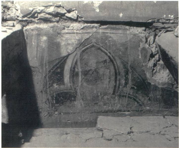
Abb. 10 Zu vergleichen sind die spitzbogigen Fenster im «Schönen Haus» mit der Imitationsmalerei (heute verdeckt) im Condé-Zimmer des Engelhofes (Nadelberg 4). (Foto: Paul Denfeld, 1967)
