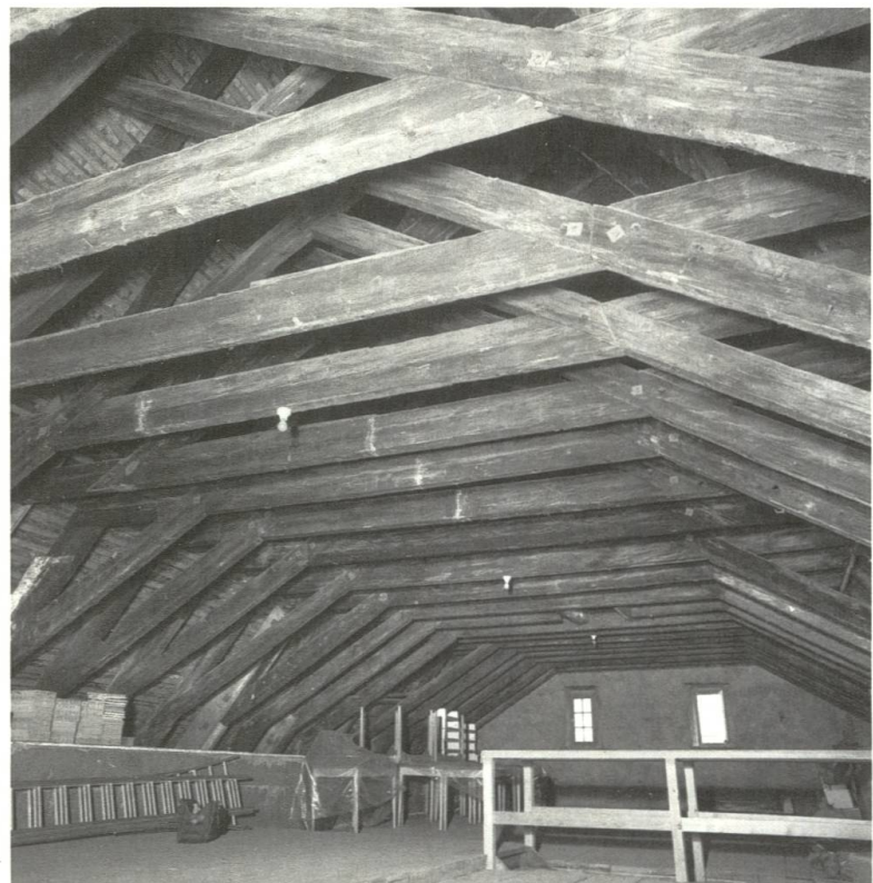
Abb. 17 Das Dachwerk im «Schönen Haus» gehört zusammen mit demjenigen im «Zerkindenhof» (Nadelberg 10) zu den ältesten Beispielen von Dachkonstruktionen in städtischen Wohnhäusern Basels. (Foto: H.R. Clerc, 1982)
