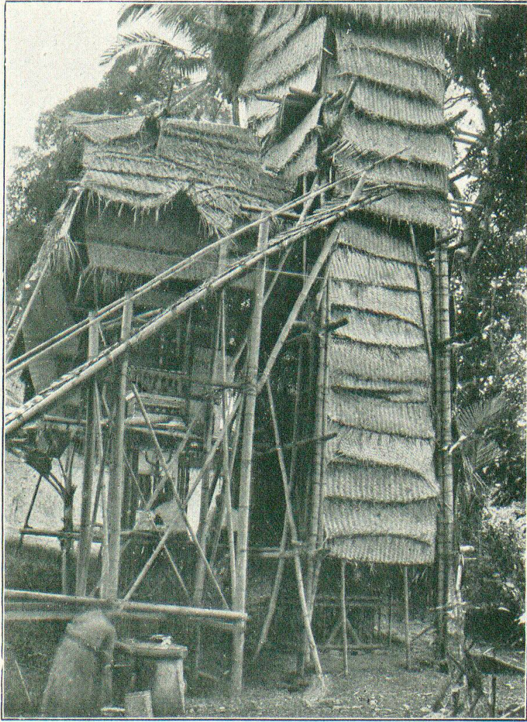
Abb. 1. Ein im Bau befindlicher Verbrennungsturm (wadah).
