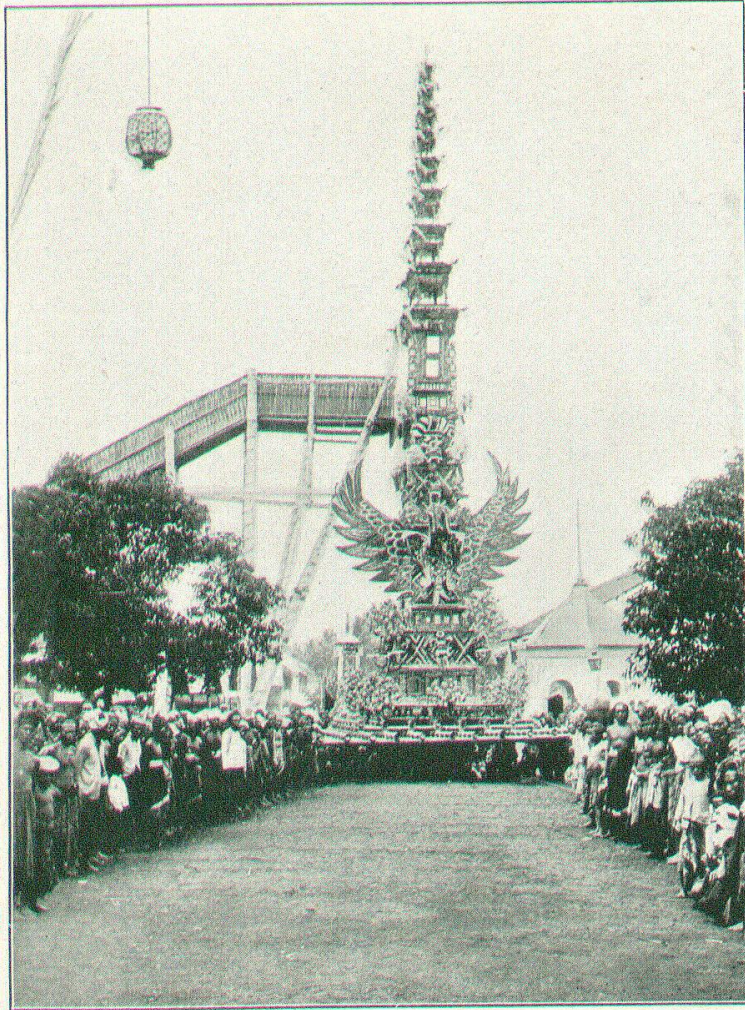
Abb. 2. Der vollendete Verbrennungsturm (wadah).
