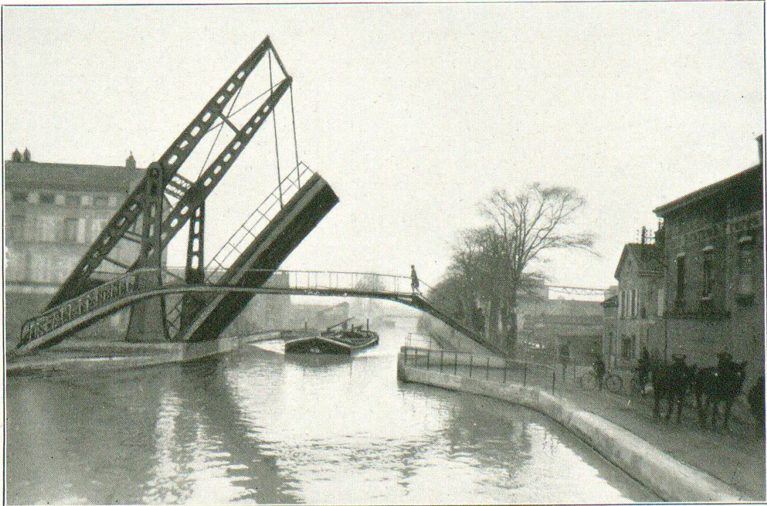
Abb. 5. Zugbrücke über den Kanal bei Nancy.
