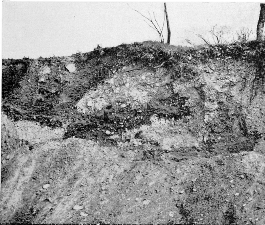
Fig. 10 Schützenhubel: Eistektonik. Paket von schottriger Moräne in Lehmsand eingewickelt (Photo A. BÖGLI).
