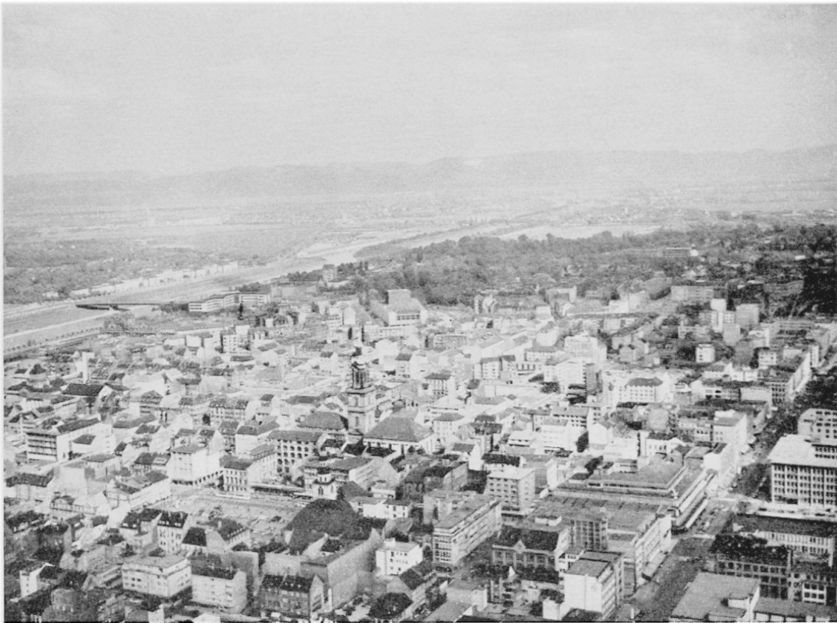
Mannheim. Blick auf östliche Innenstadt, kanalisierten Neckar und Odenwald mit Bergstraße. Photo Bildarchiv des Verkehrsvereins Mannheim.
