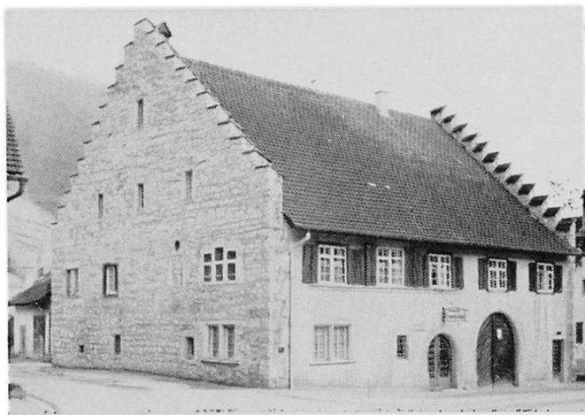
Abbildung 23. Traufständiges spätgotisches Staffeldgiebelhaus in Merishausen. Um 1595 als Gemeindehaus erbaut. An der Schmalseite unverputztes Mauerwerk aus Bruchkalkstein. Hauptfront mit Wohnhaus (links), Tenn und Stall (rechts), also Mittertennhaus
