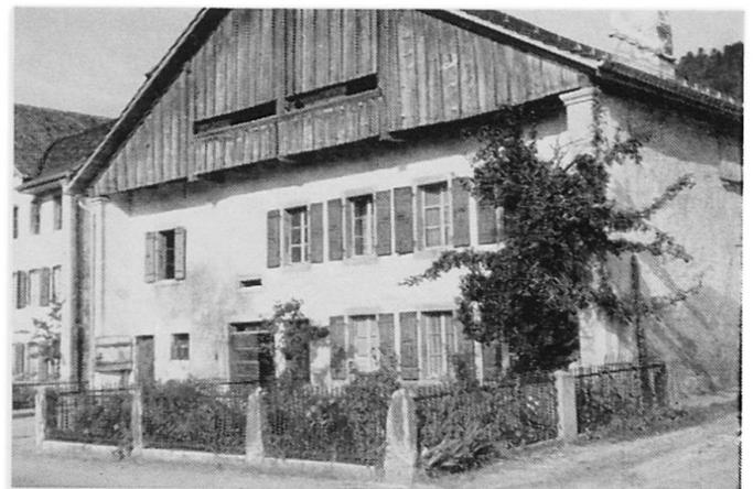
Photo 2. Ferme-pignon de Dombresson à tripartition longitudinale du rez-de-chaussée: étable, fourragère et logement. Brise-vent à chaque extrémité de la façade. Fentes d'aération de la grange aménagées dans la façade-pignon
