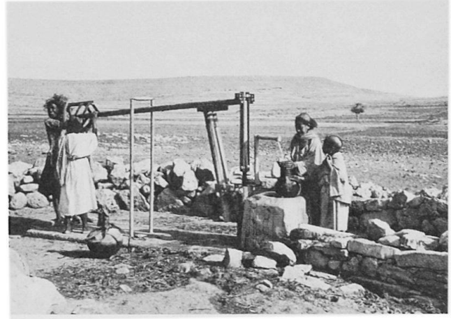
Abb.3: Mit Handpumpe ausgerüsteter Bohrbrunnen in der Tigre Provinz
