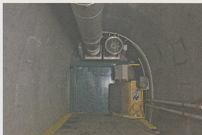
Cunicolo trasversale con attrezzatura completa.
