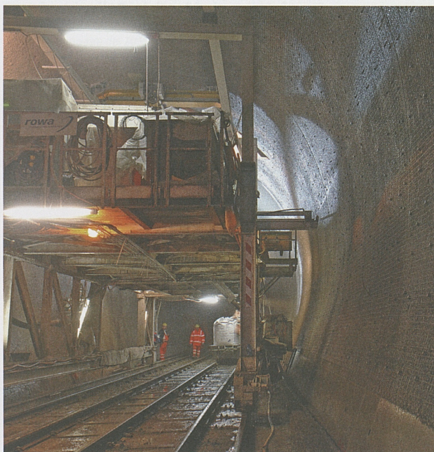
Posa dello strato di protezione antincendio.
