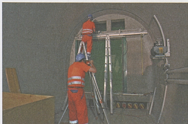
Installazione della porta in un cunicolo trasversale.
