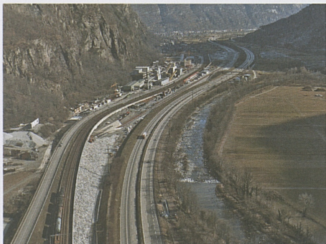
Ripresa aerea dei cantieri di Pollegio e Bodio in direzione sud.
