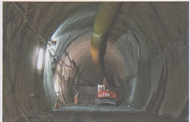
Vezia: avanzamento dello strozzo.
