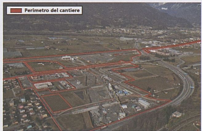
Nodo di Camorino: perimetro del cantiere.
