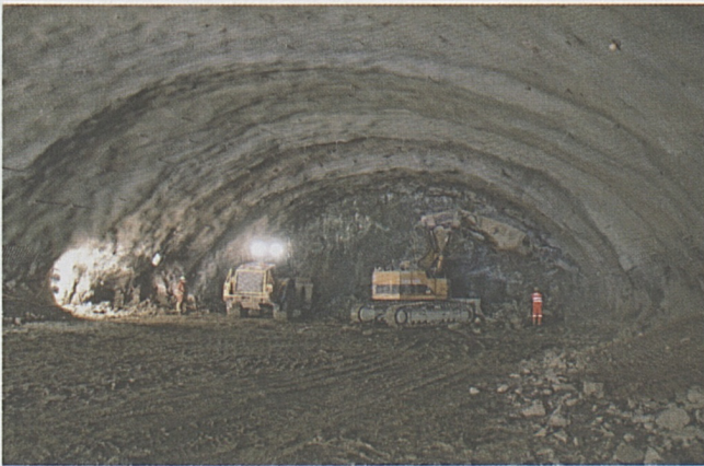
Vigana: avanzamento in calotta.
