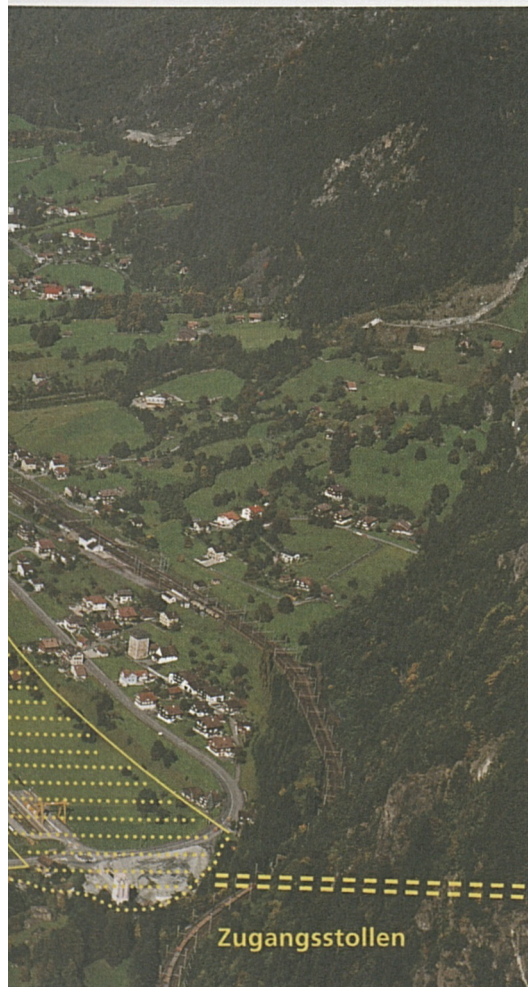
Luftaufnahme von Silenen, Sommer 1999; der Blick geht Richtung Norden. Die Ebene zwischen den beiden Wohnquartieren Grund und Dörfli in Silenen wird zur Grossbaustelle.
