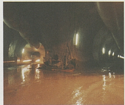
In Bodio sind schon mehr als 1000 m des neuen Gotthard-Basistunnels ausgebrochen worden.
