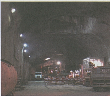
In Sedrun wird zurzeit eine neue leistungsstarke Schachtförderanlage eingebaut.
