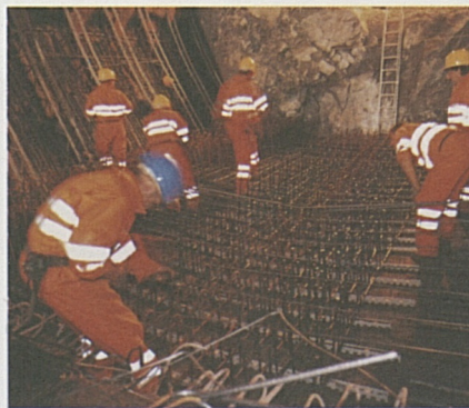
In Faido am Fusspunkt des 2700 m langen Zugangsstollens wird hart gearbeitet.
