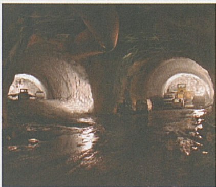
Ausbruch der Multifunktionsstelle Faido.
