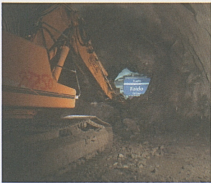
Durchstich in der Lockergesteinsstrecke.
