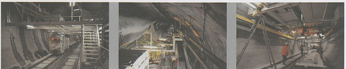
Der rund 400 Meter lange Nachläufer der TBM S-229 ist eine richtige Fabrik mit verschiedensten Maschinen und Installationen.
