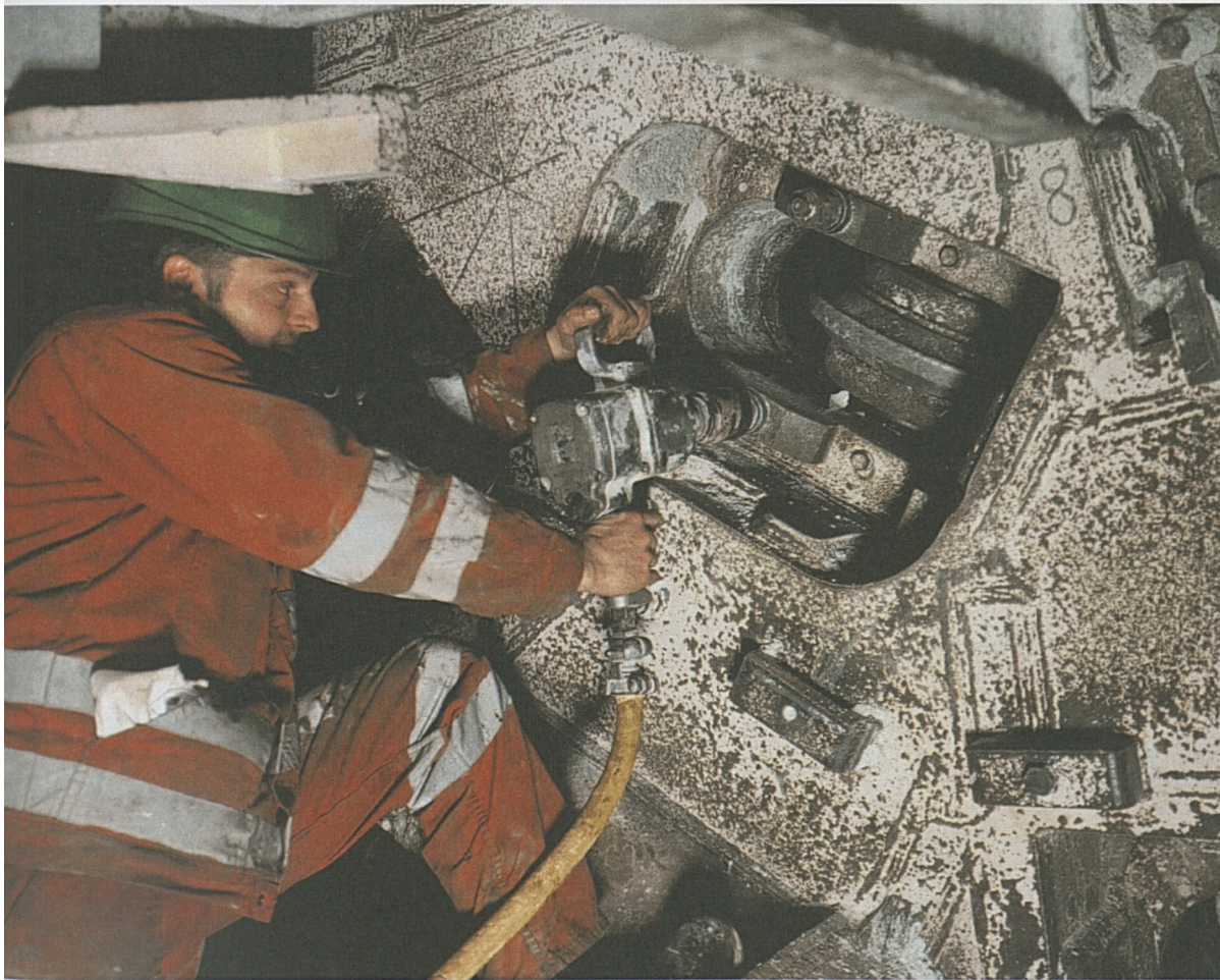
Harte Arbeit für die Mineure: Die 62 Rollenmeissel müssen regelmässig ausgewechselt werden. Ein Rollenmeissel wiegt nicht weniger als 150 kg.
