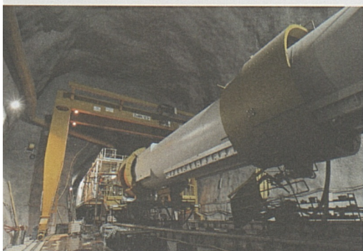
Für die TBM-Montage brauchte es zwei grosse Portalcrane mit einer Tragkraft von 2 x 80 Tonnen.
