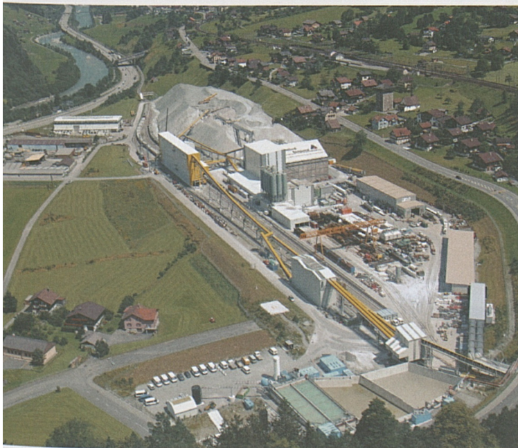
Luftaufnahme der ATG-Baustelle Amsteg.
