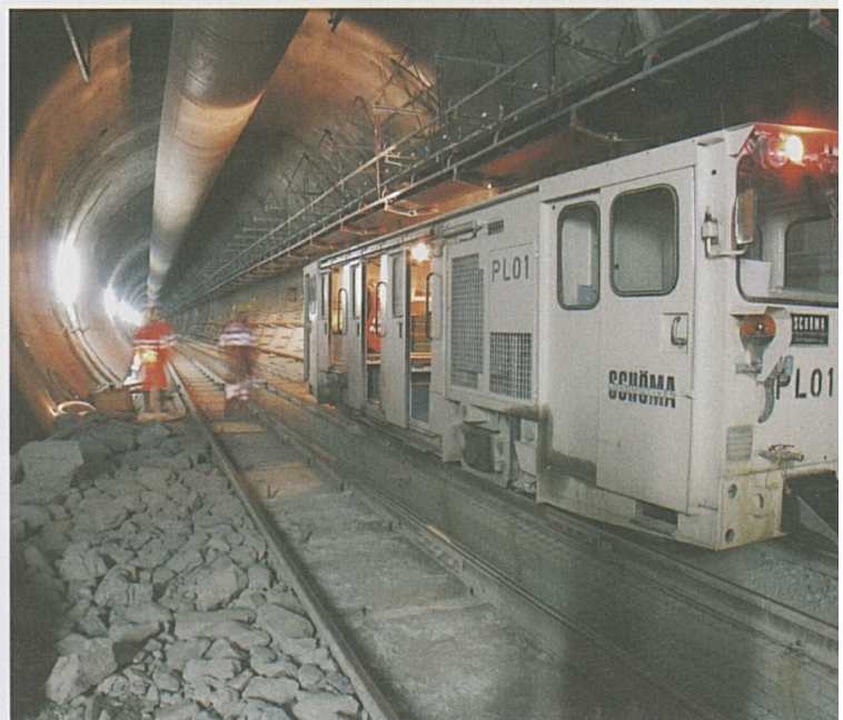
Stollenbahn in der Weströhre des Gotthard-Basistunnels.
