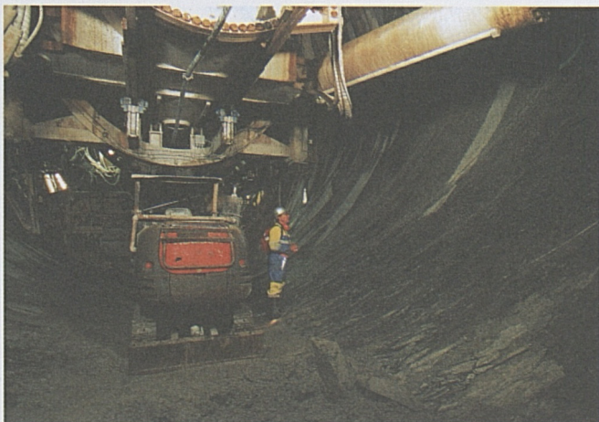
Kontrollgang der örtlichen Bauleitung zum Vortrieb.
