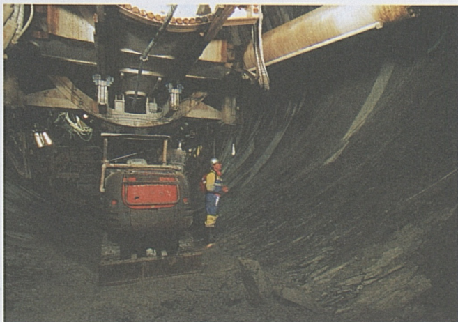
Kontrollgang der örtlichen Bauleitung zum Vortrieb.
