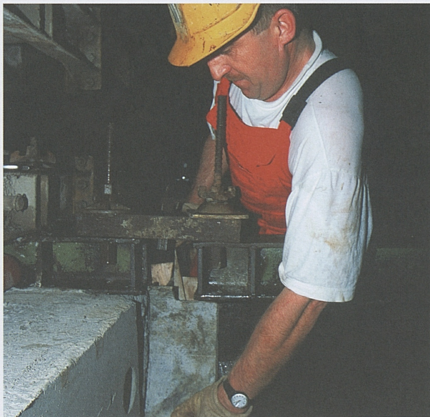
Auf der ATG-Baustelle Amsteg arbeiten mehr als 300 Mineure.
